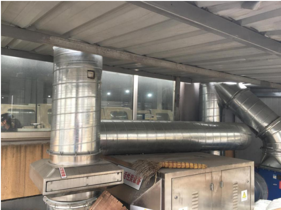
图4-2 干式过滤器+活性炭装置
