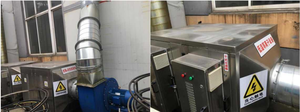
图4-1 低温等离子+干式过滤器+光氧+活性炭装置
